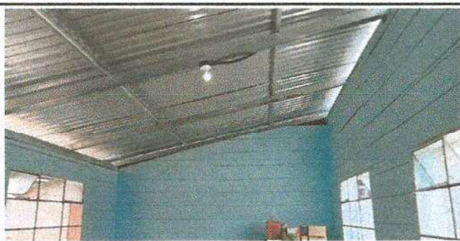
Foto 3: Se observa el interior de uno de los salones del módulo 1, con estructura de metal y láminas troqueladas totalmente nuevas, las puertas rectificadas y los vidrios de ventanas instaladas.
