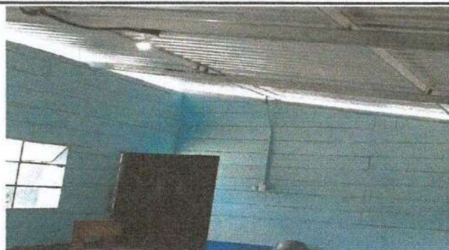
Foto1: Se observa los nuevos suministros e instalaciones de sistema eléctrico en el módulo 1, 2 y 3.
