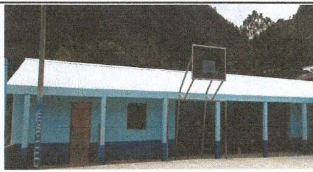
Foto 2: Se observa la nueva instalación de láminas troqueladas en el módulo 2.
