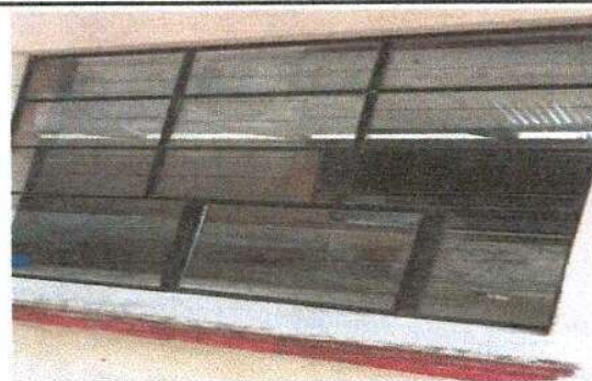
Foto 6: Se observa el vidrio nuevo instalado en la ventana del modulo 3.
